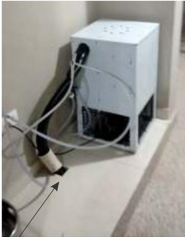
Detalhe de instalação remota. Na foto pré-resfriador com a tubulação subterrânea
